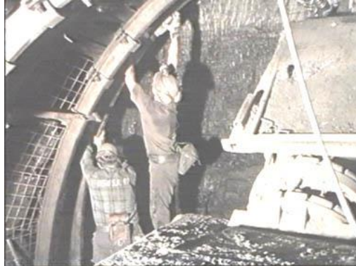
Budowa obudowy chodnikowej
