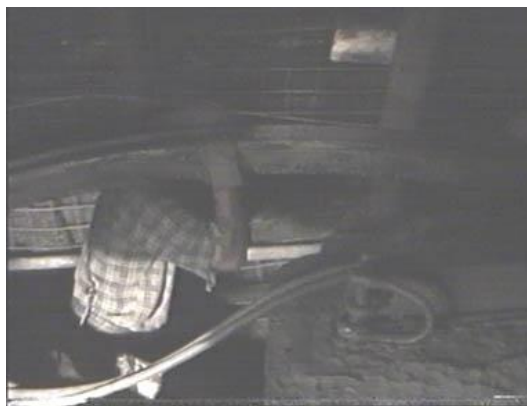
Transport części obudowy chodnikowej
