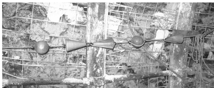
Rys. 2.7 Oznakowanie przejścia na drugą stronę wyrobiska
