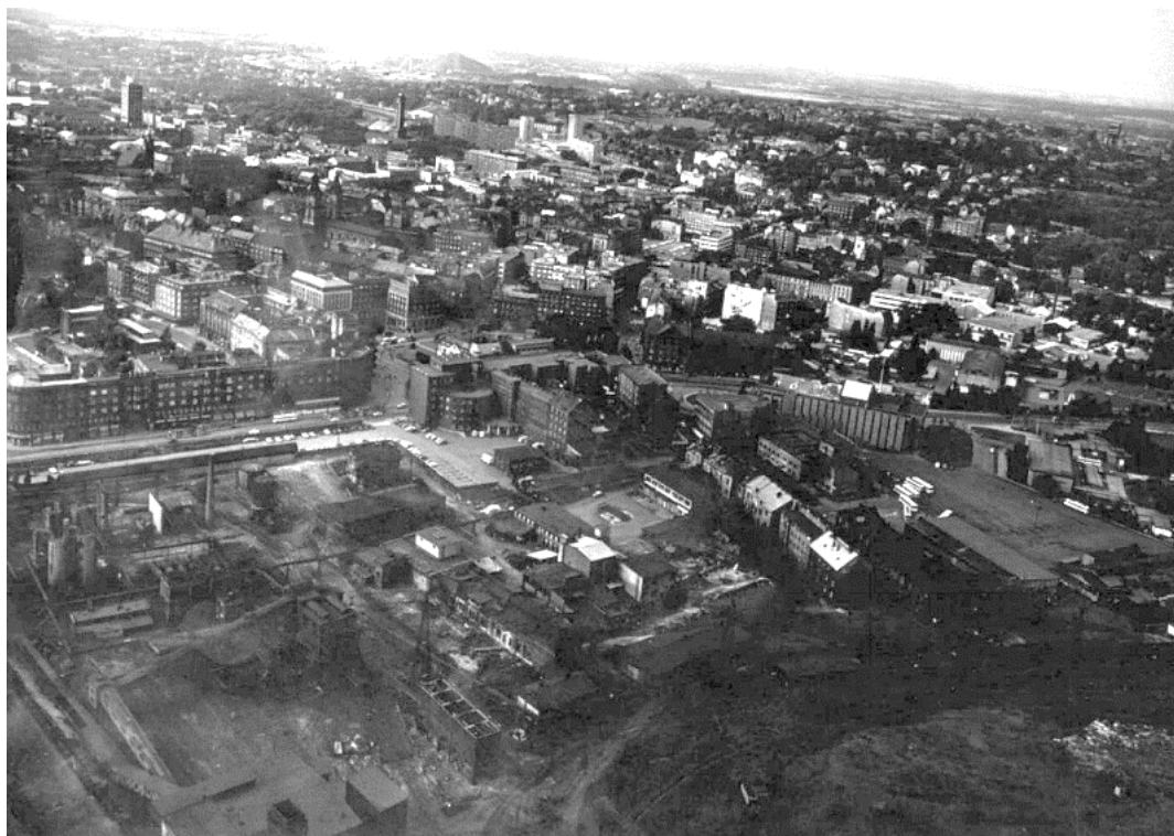
Rys. 10.2 Dzielnica Karolina po wyburzeniu koksowni
