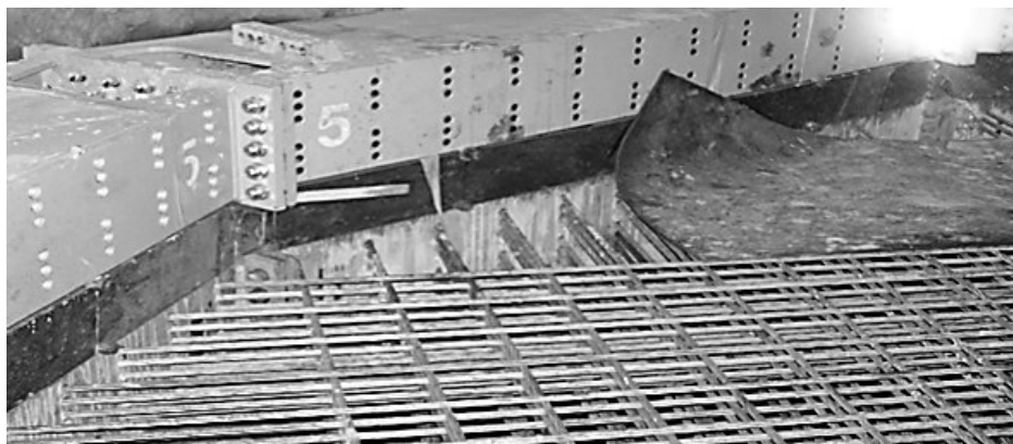
Rys. 17.3 Zabudowa sztucznego dna
