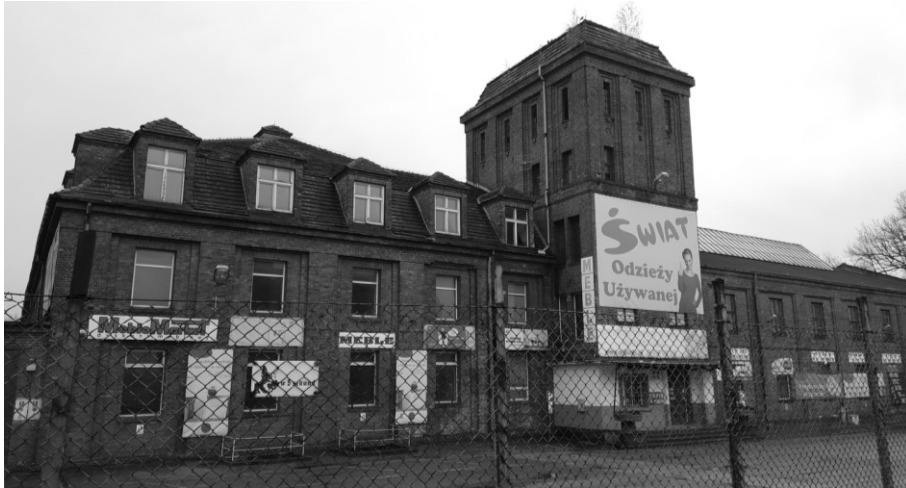
Rys. 21.15 Teren „Sośnica Wschód” – główny budynek
