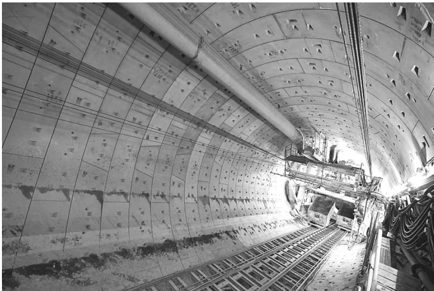
Rys. 26.7 Widok wykonywanego tunelu dostępowego (upadowej) do stacji metra
