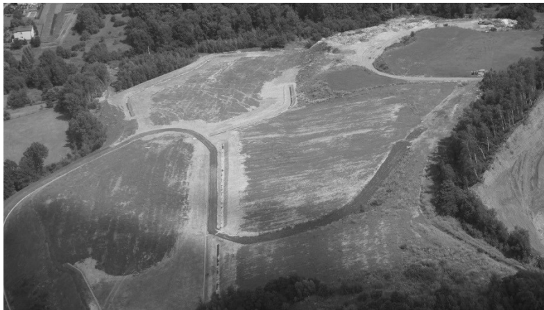
Rys 43.16 Teren byłego zwałowiska po zakończonej rekultywacji i wykonanym odwodnieniu
