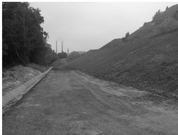
Rys. 43.8 Rów opaskowy i zrehabilitowana skarpa od strony zachodnie - rok 2014
