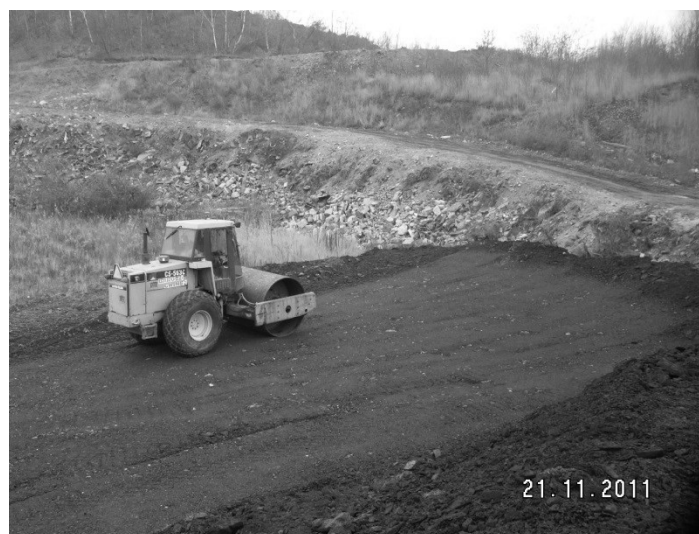
Rys. 43.13 Zagęszczenie następnej warstwy odpadów wydobywczych
