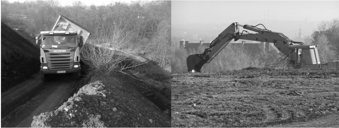
Rys. 43.12 Wykonywanie prac związanych z rekultywacją techniczną
