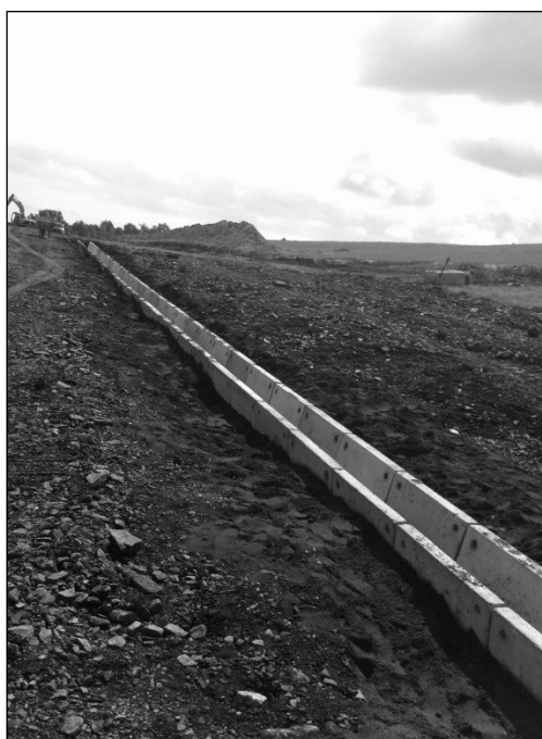
Rys 43.15. Wykonywanie rowów odwadniających
