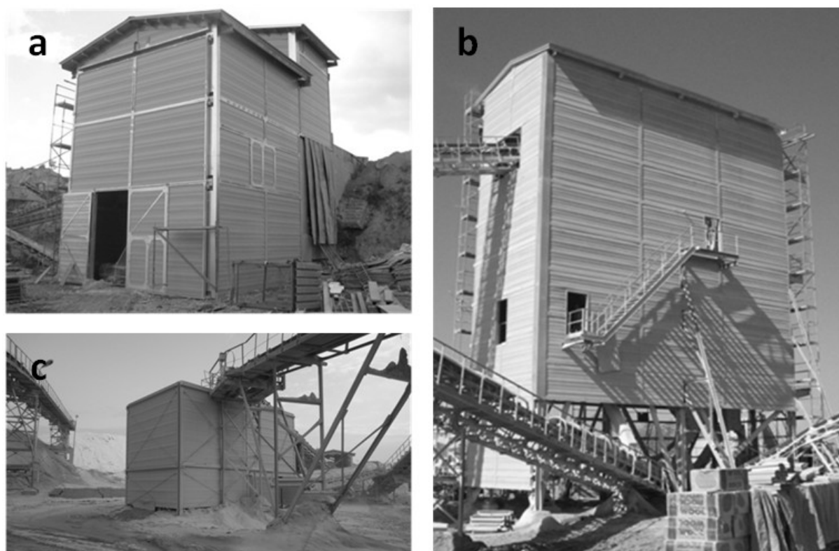
Rys. 6.6 Przykładowe zabezpieczenia przeciwhałasowe źródeł
