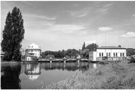
Zdj. 7. Elektrownia wodna Gubin
