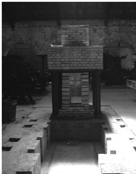
Rys. 2. Zdjęcie fundamentu z dolną częścią komina i czopuchem
