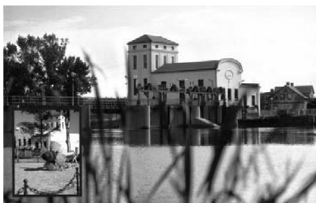
Zdj. 3. Elektrownia wodna Gorzupia
