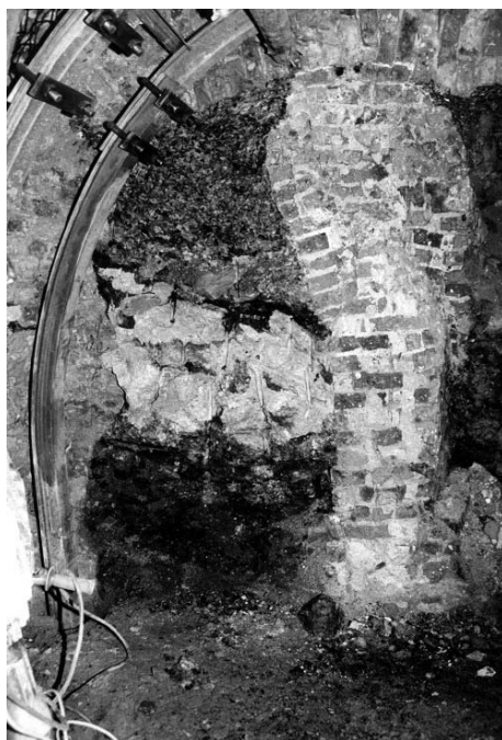
Zdjęcie nr 6. Fragment dawnej obudowy murowej w sztolni
