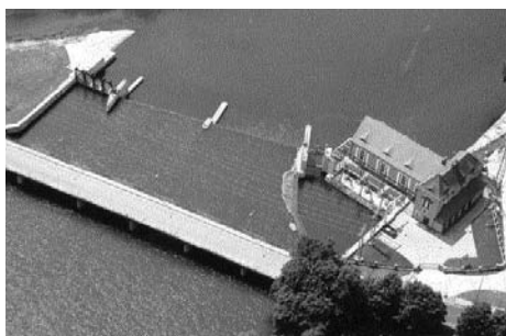
Zdj. 5. Elektrownia wodna Żagań I
