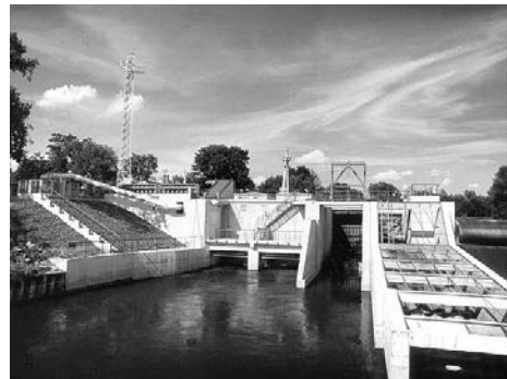
Zdj. 10. Elektrownia wodna Przysieka
