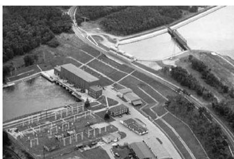
Zdj. 1. Elektrownia wodna w Dychowie
