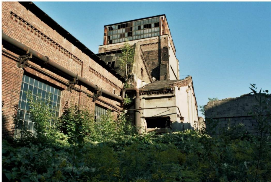
Fot. 7: Budynki kubaturowe w likwidacji w rejonie ul. Moniuszki - KWK Paryż w Dąbrowie Górniczej
