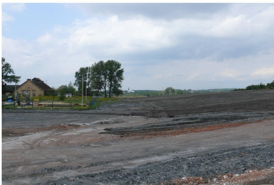
Fot. 50: Rekultywacja techniczna placu rozładunkowego i bocznic kolejowej KWK Grodziec w Wojkowicach w rejonie ul. Górniczej (rok 2008)
