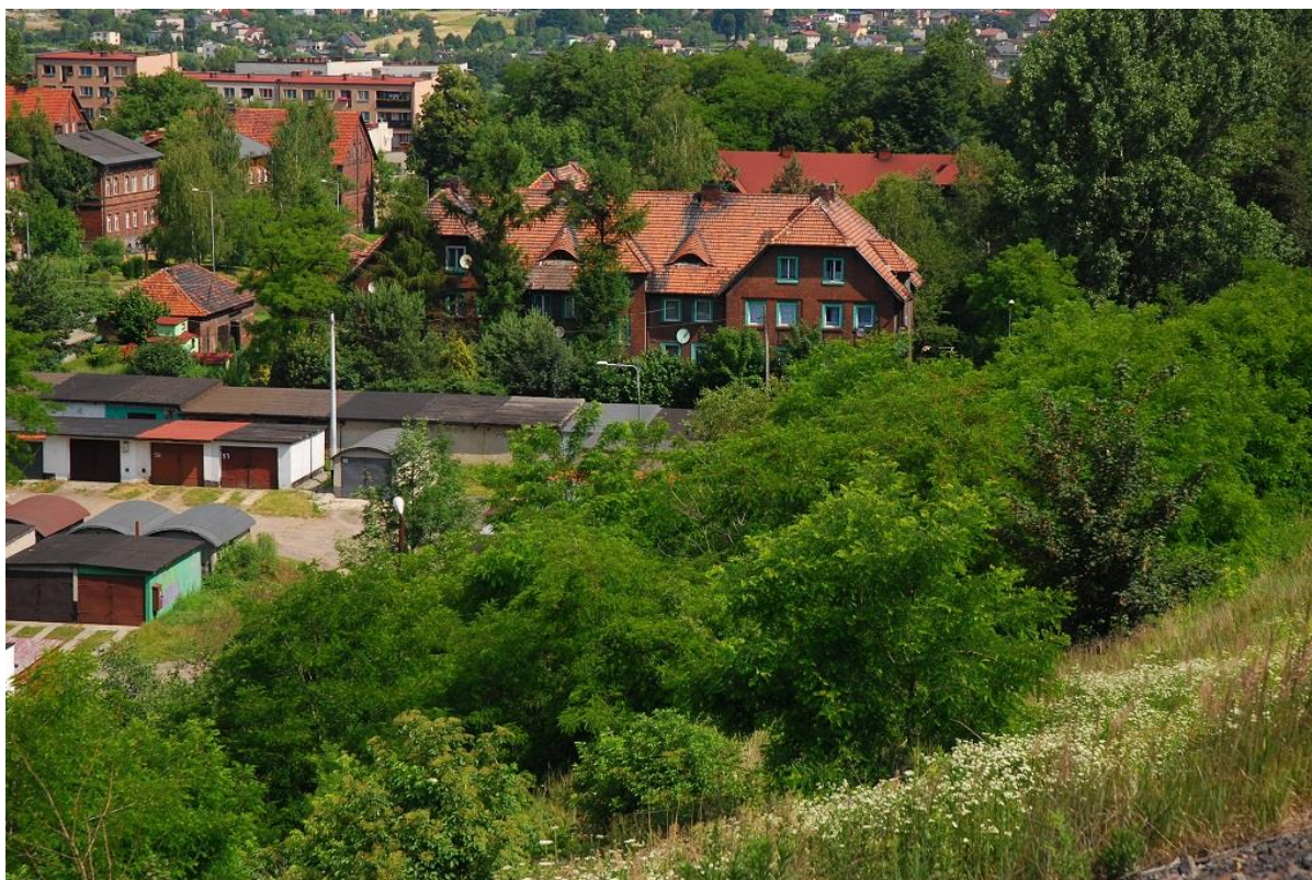
Rys. 17. W bezpośrednim sąsiedztwie zapożarowanej hałdy zlokalizowane są osiedla mieszkaniowe
