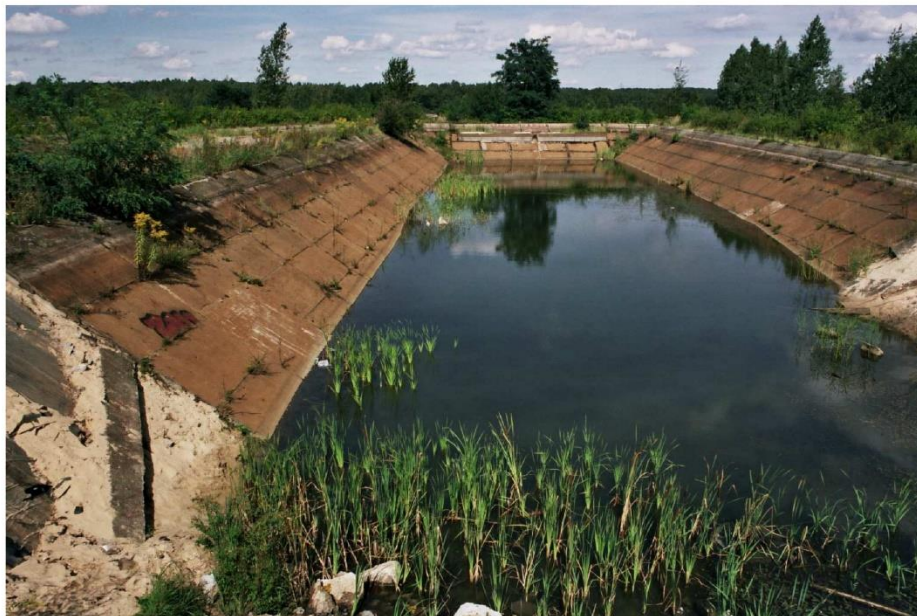
Fot. 9: Likwidowane betonowe osadniki wypełnione wodą opadową w rejonie ul. Kosynierów. Obraz początkowego stadium zarastania szuwarem szerokopalkowym - KWK Porąbka-Klimontów w Sosnowcu
