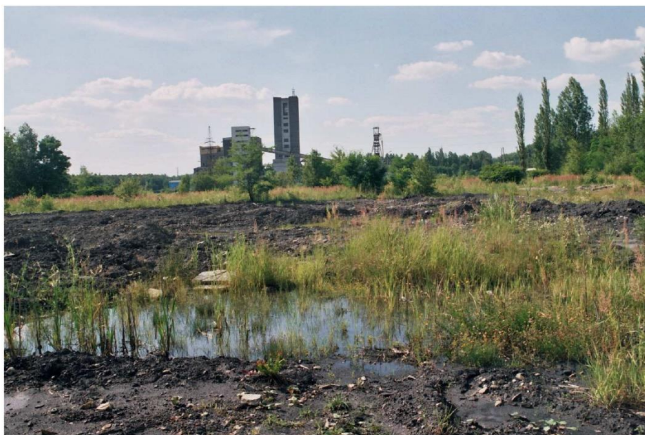
Fot. 10: Teren po placach składowych w rejonie Szybu Witold I - KWK Jan Kanty w Jaworznie. W lokalnych obniżeniach terenu wypełnionych wodą widoczny rozwój zbiorowisk bagiennych
