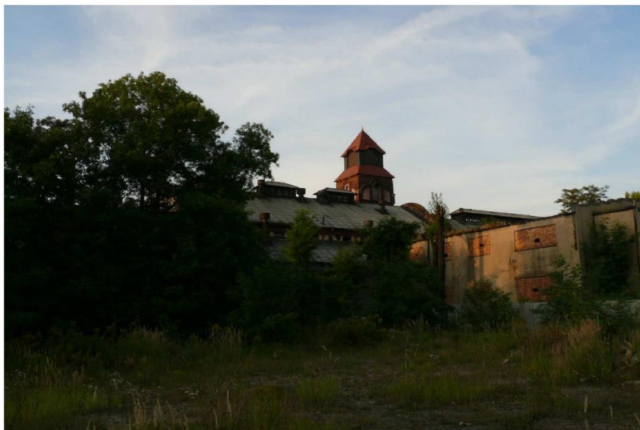
Fot. 3: Fragment historycznej zabudowy kubaturowej z XIX w. przy ul. Dehnelów w Czeladzi - KWK Saturn
