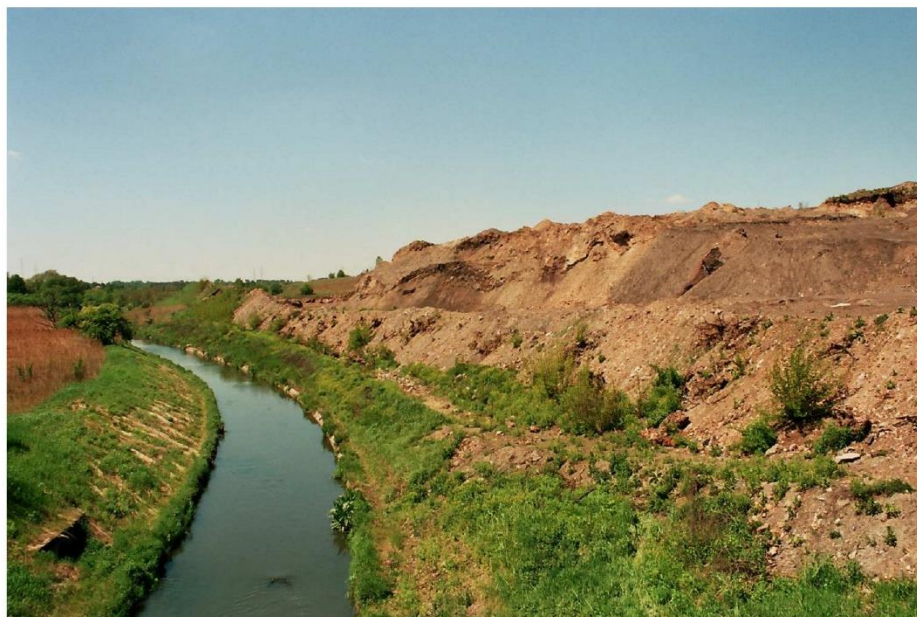
Fot. 47: Zwałowisko odpadów powęglowych KWK Jowisz w Wojkowicach w rejonie ul. Wiejskiej (rok 2005)
